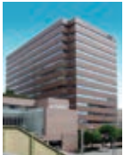
新大阪ブリックビル外観
